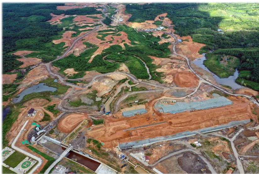
Рис.5. Строительные работы. Источник: URL: https://www.thejakartapost.com/business/2023/03/08/construction-progress-on-core-ikn-region-hits-23.html
